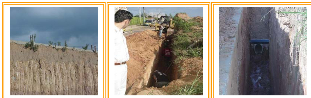
Figura 2. Trabajos de Desmonte de la Tubería abandonada por el Acueducto
