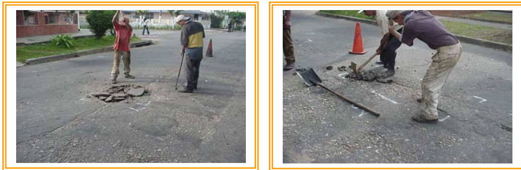
Figura 18. Demolición Pavimento Existente
