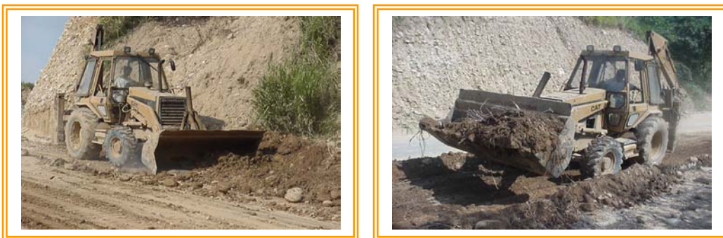
Figura 28. Cargador Trabajando en la Remoción de Escombros
