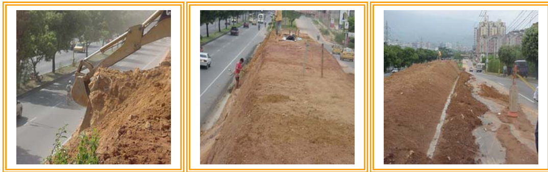
Figura 4. Trabajos de conformación del Talud a 45°
