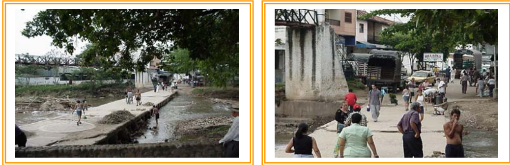
Figura 5. Situación Actual de la Batea existente en “El Malecón” Girón
