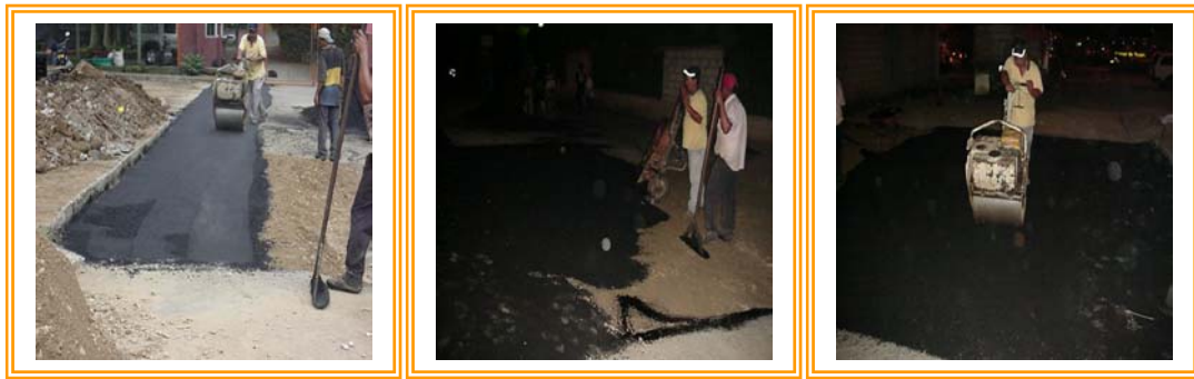
Figura 8. Compactación Mezcla Asfáltica
