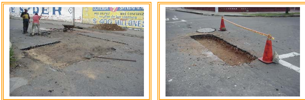
Figura 19. Excavación Base Granular Existente
