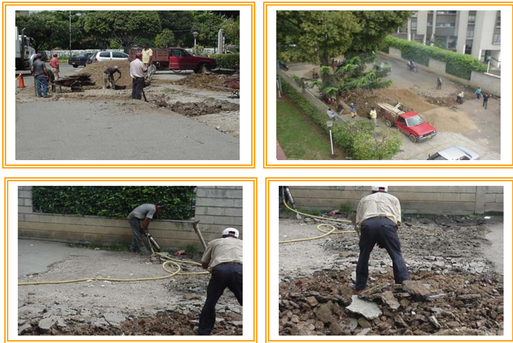
Figura 6. Trabajos de Demolición para la Construcción de la Base del Pavimento
