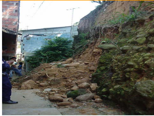
Figura 34. Deslizamiento Barrio San Martín
