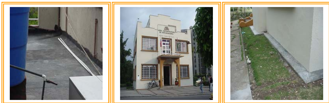
Figura 14. Resultados de Ejecución Contrato de Obra Pública No 035 de 2004
