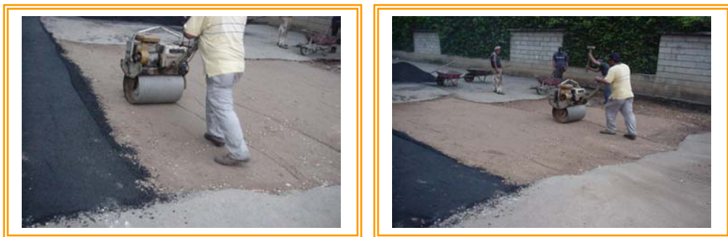
Figura 7. Compactación Material Granular de la Base del Pavimento
