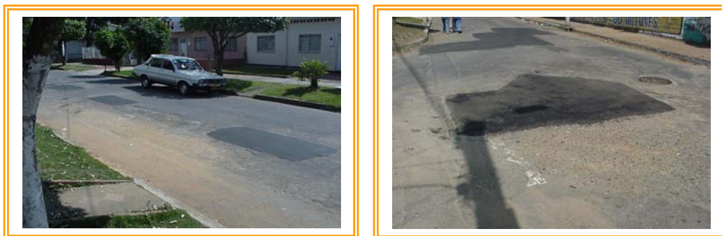
Figura 21. Resultados Ejecución Orden de Trabajo No 004 de 2004
