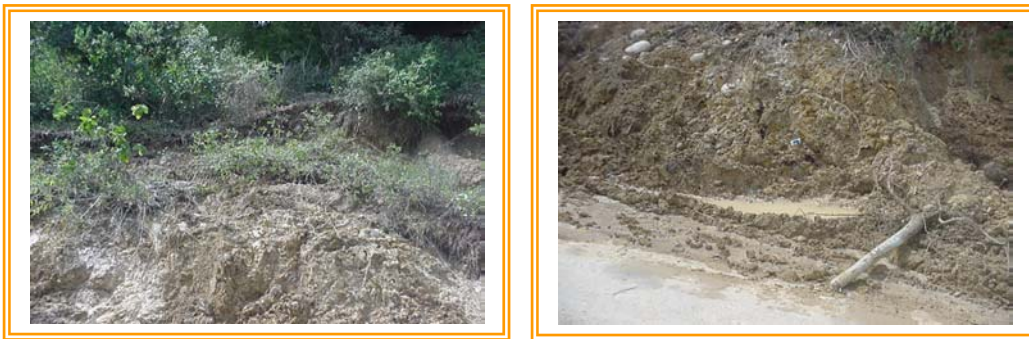
Figura 27. Derrumbes en la Vía Bucaramanga-Girón sentido Oriente-Occidente
