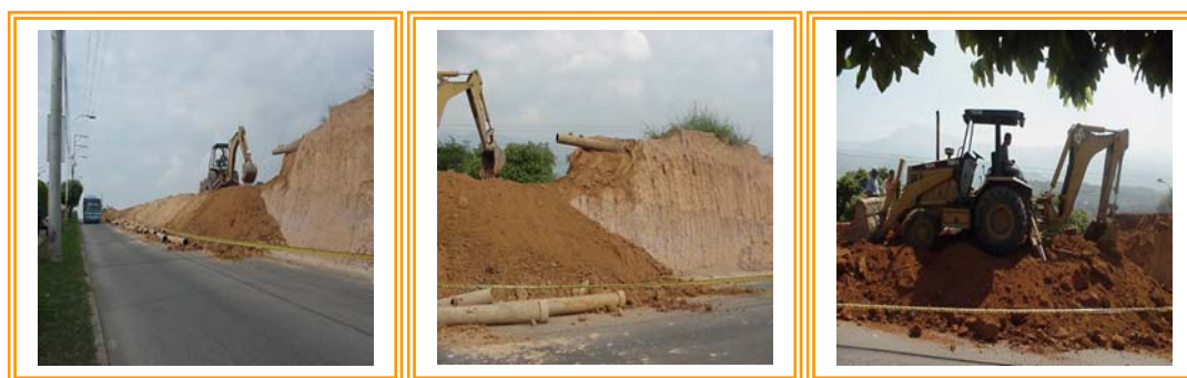
Figura 3. Movimiento de Tierra Desmonte Tubería
