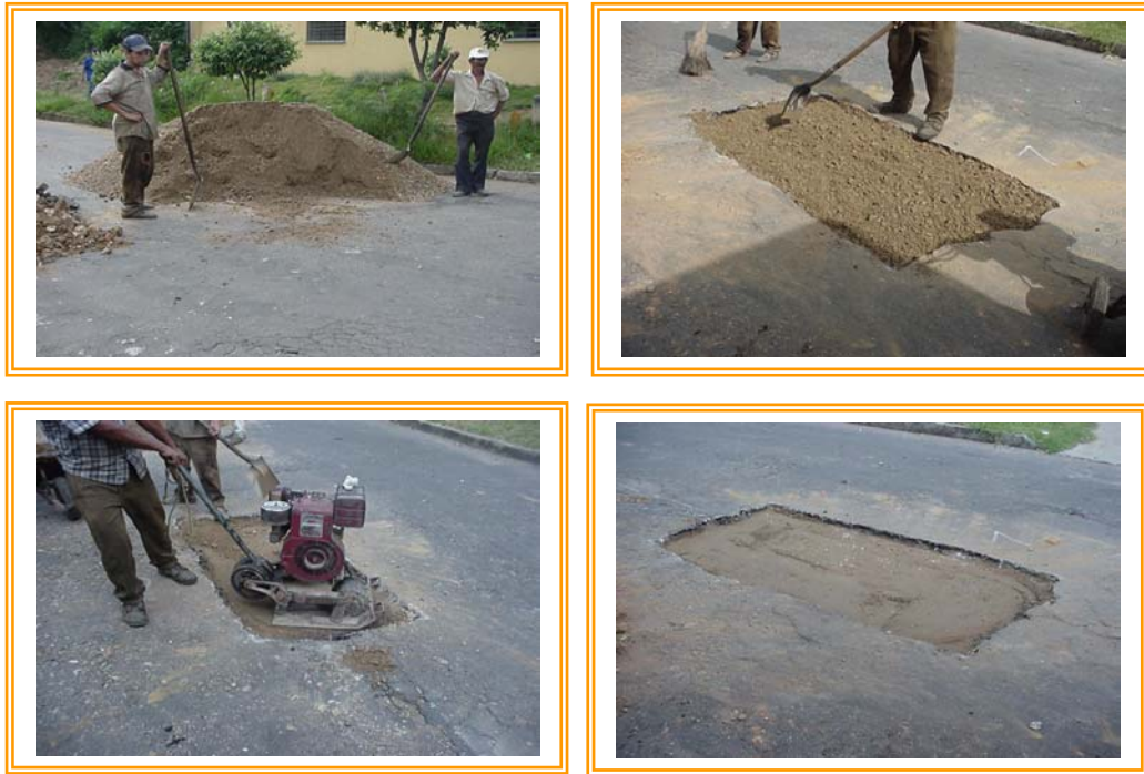
Figura 20. Suministro, Compactación y Conformación Base
