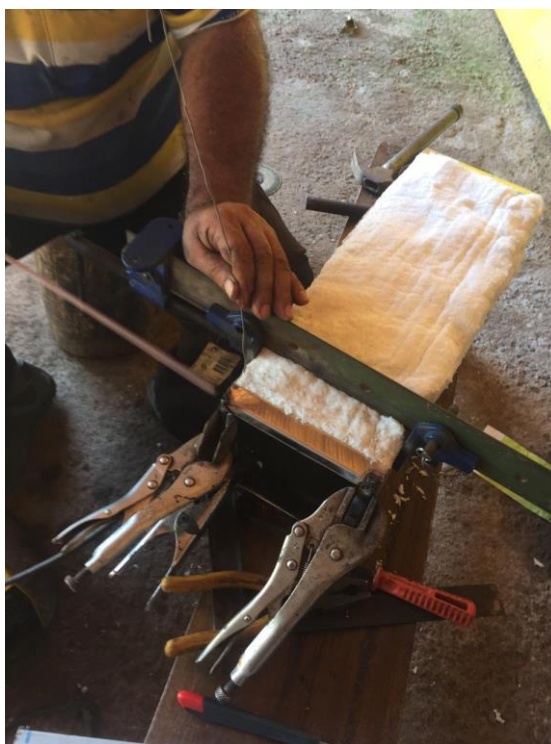
Figura 38. Instalación del aislante sobre el cajón interior.
