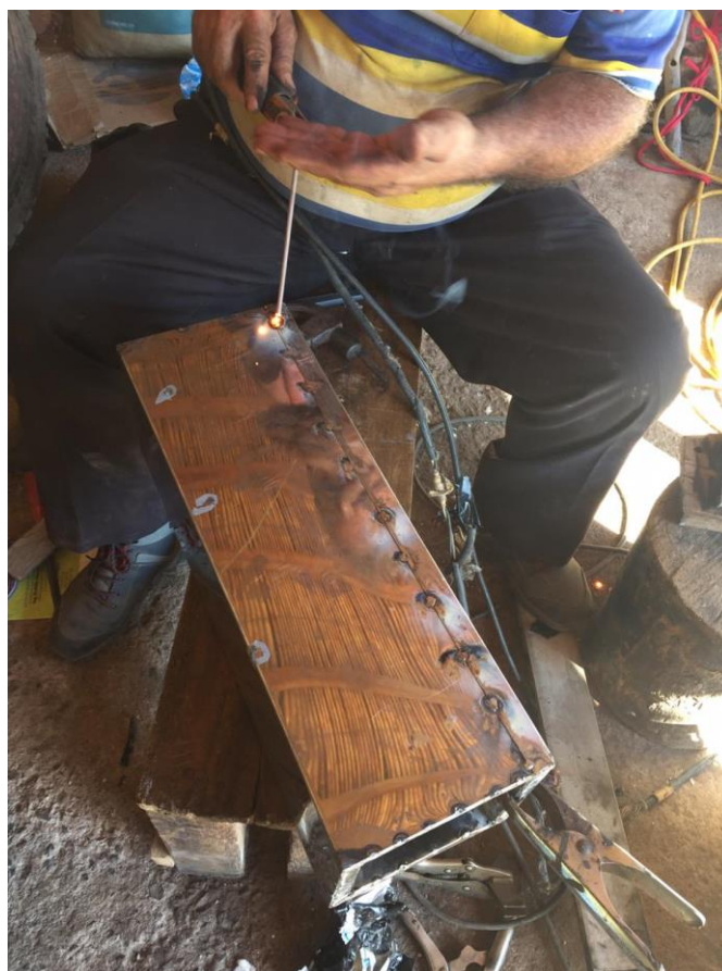
Figura 40. Soldadura cajón exterior.
