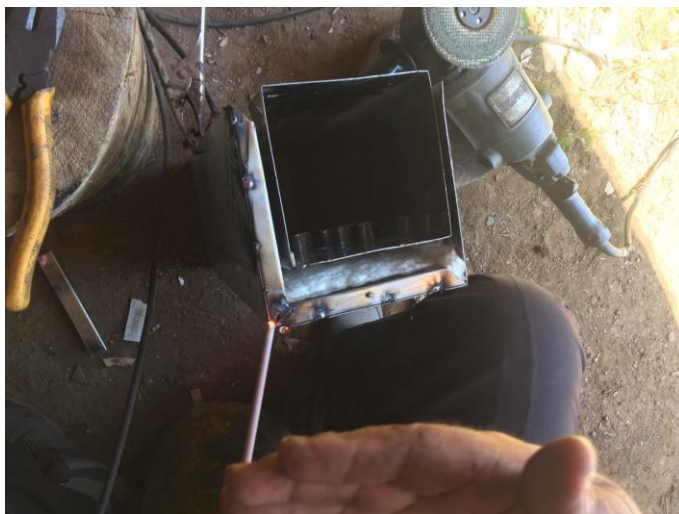
Figura 39. Soldadura marco unión entre cajón interior y exterior.
