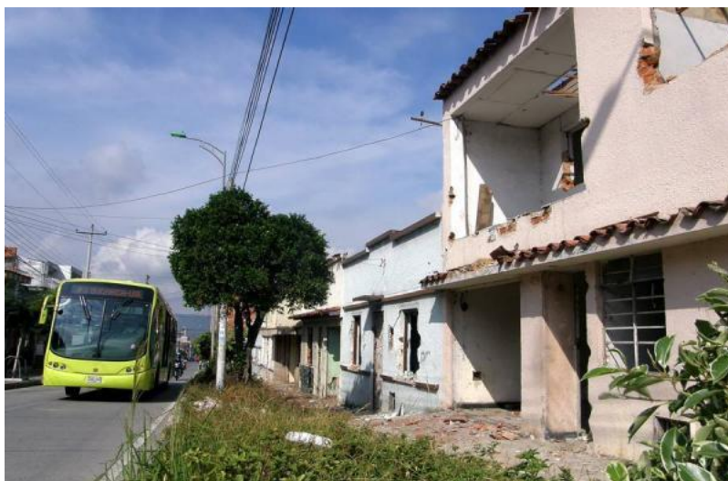
Figura 16. Casas abandonadas para la construcción de la Estación UIS de Metrolínea
