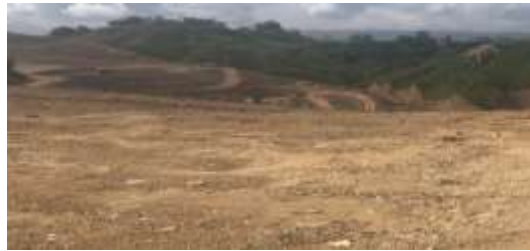
Figura 8. Estado actual de la Zona de estudio 2.
