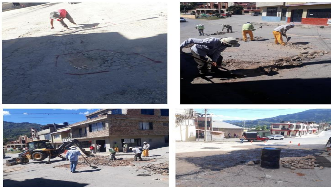
Figura 9. Reparcheo realizado en la entrada al barrio Villa Betty
