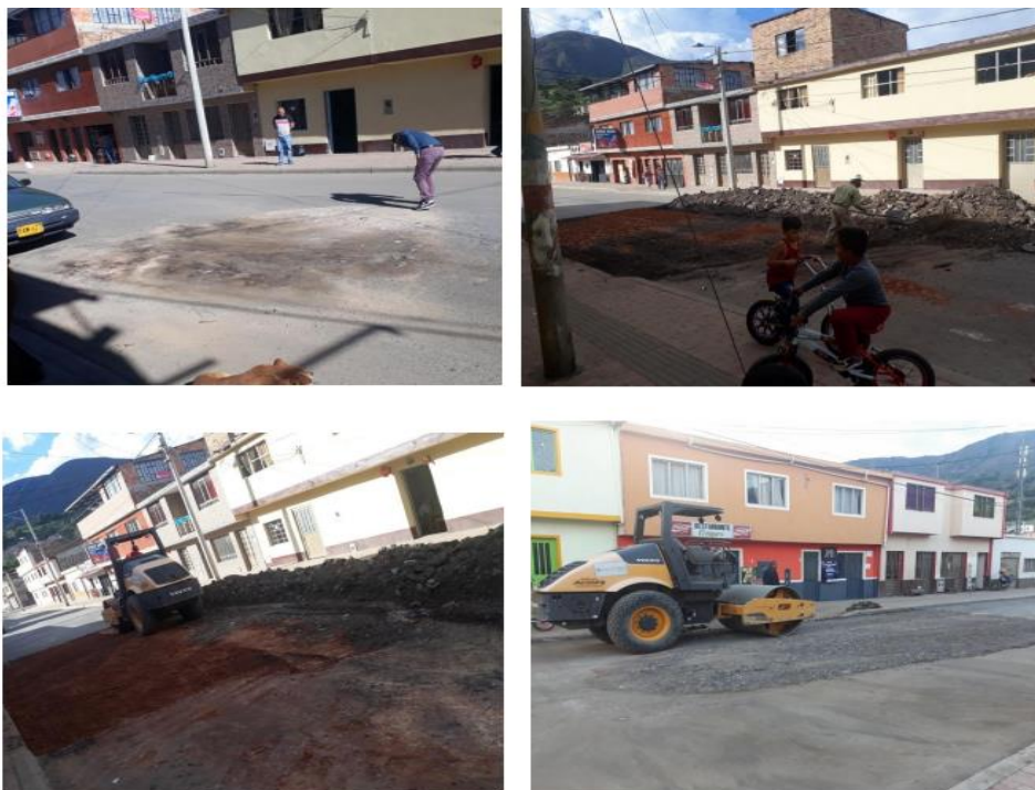
Figura 10. Reparcheo realizado en la calle 4 con carrera 5
