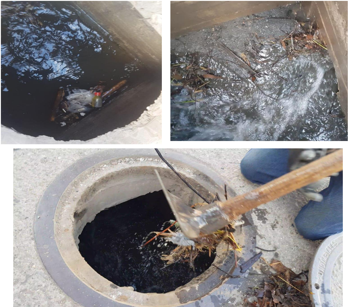
Figura 15. Visita Pozo de Inspección del Canal de Regadío de la toma el Cárcamo
