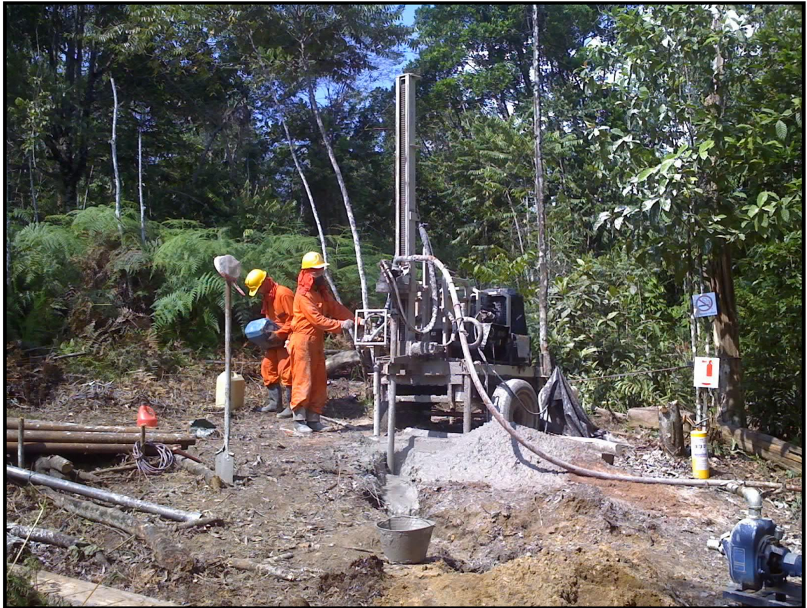
Figura 52. Proceso de perforación del pozo Uphole “Uribante”.
