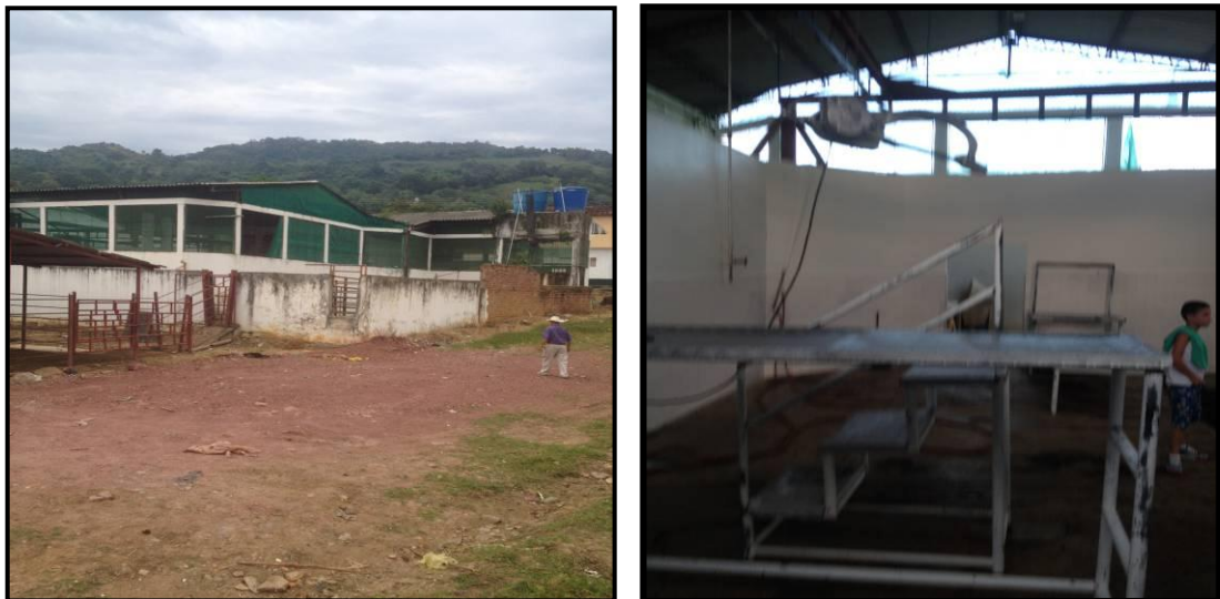
Fotografía 9. Infraestructura planta de beneficio animal de Simacota
