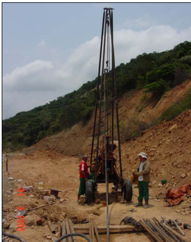
Foto 6. Equipo de perforación a rotación en el sitio del sondeo 1
