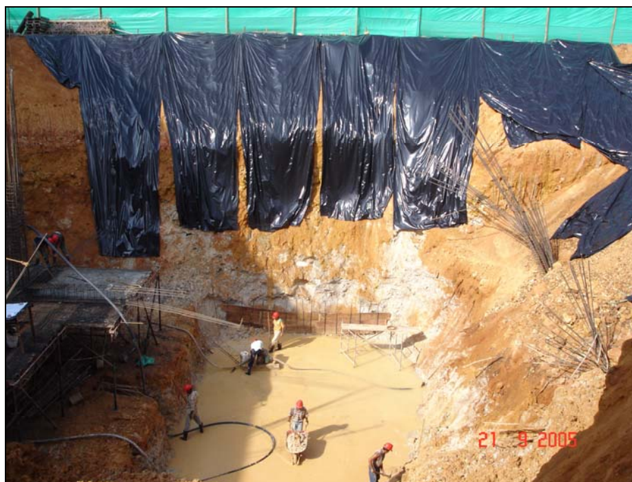
Foto 8. Zona de excavación con apreciación del nivel freático.
