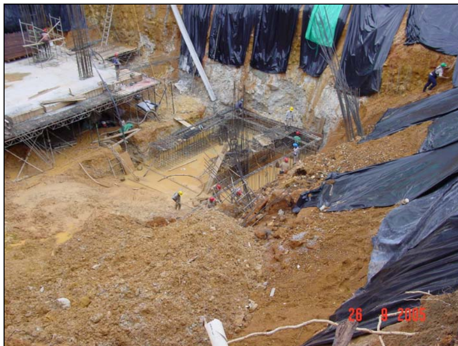
Foto 7. Zona de excavación.
