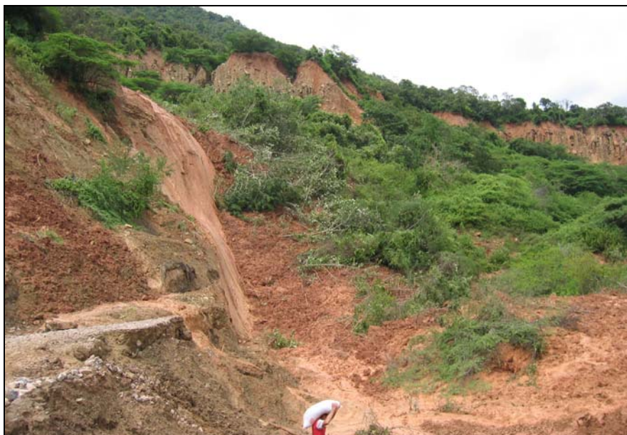
Foto 1. Deslizamiento en el sitio Cúcuta - La china.
