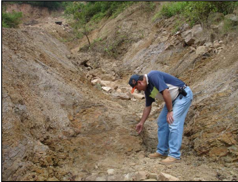
Foto 3. Afloramiento de lodolitas grises, laminadas y fracturadas, ligeramente plegadas en la zanja norte que limita el deslizamiento.
