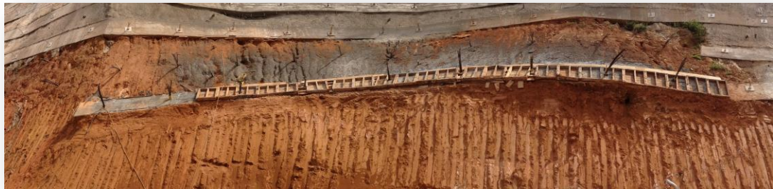
Imagen 9. Viga anclada K10+700 vía Bucaramanga – Cúcuta. Consorcio vías nacionales.
