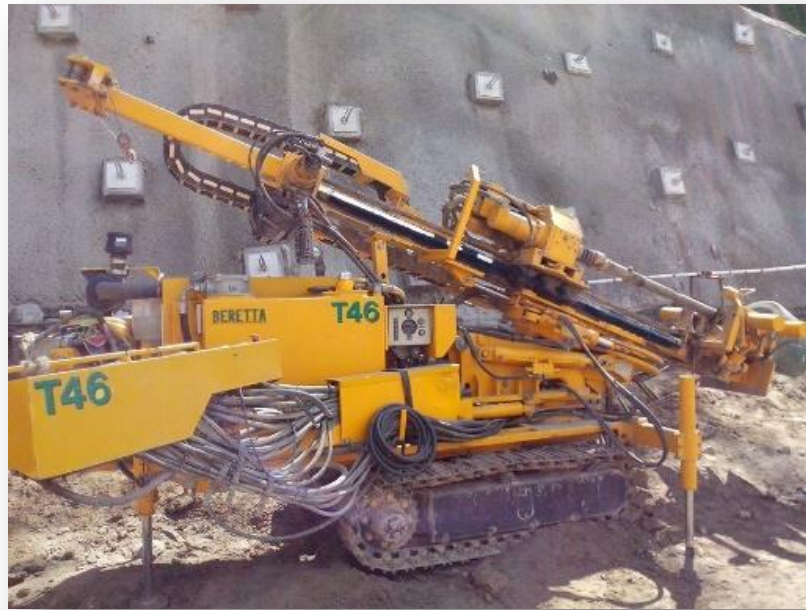
Figura 4. Maquinaria de perforación.
