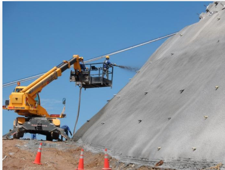
Imagen 7. Lanzado de concreto
