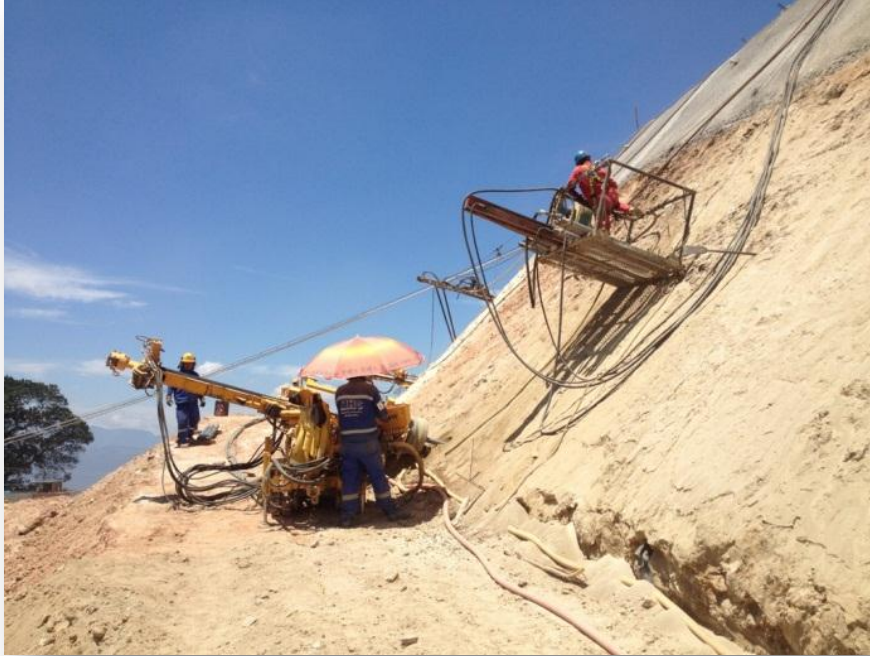
Imagen 3. Proceso de perforación
