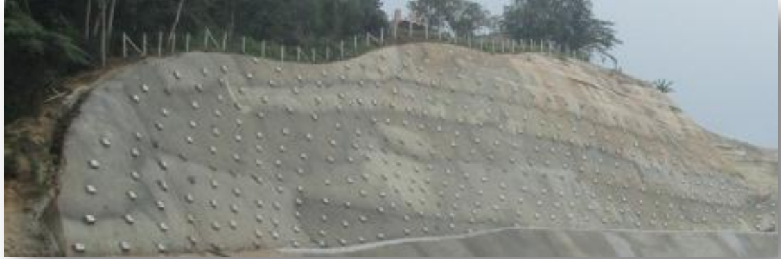
Imagen 10. Pantalla anclada (con anclajes activos) K10+700 vía Bucaramanga – Cúcuta. Consorcio vías nacionales.
