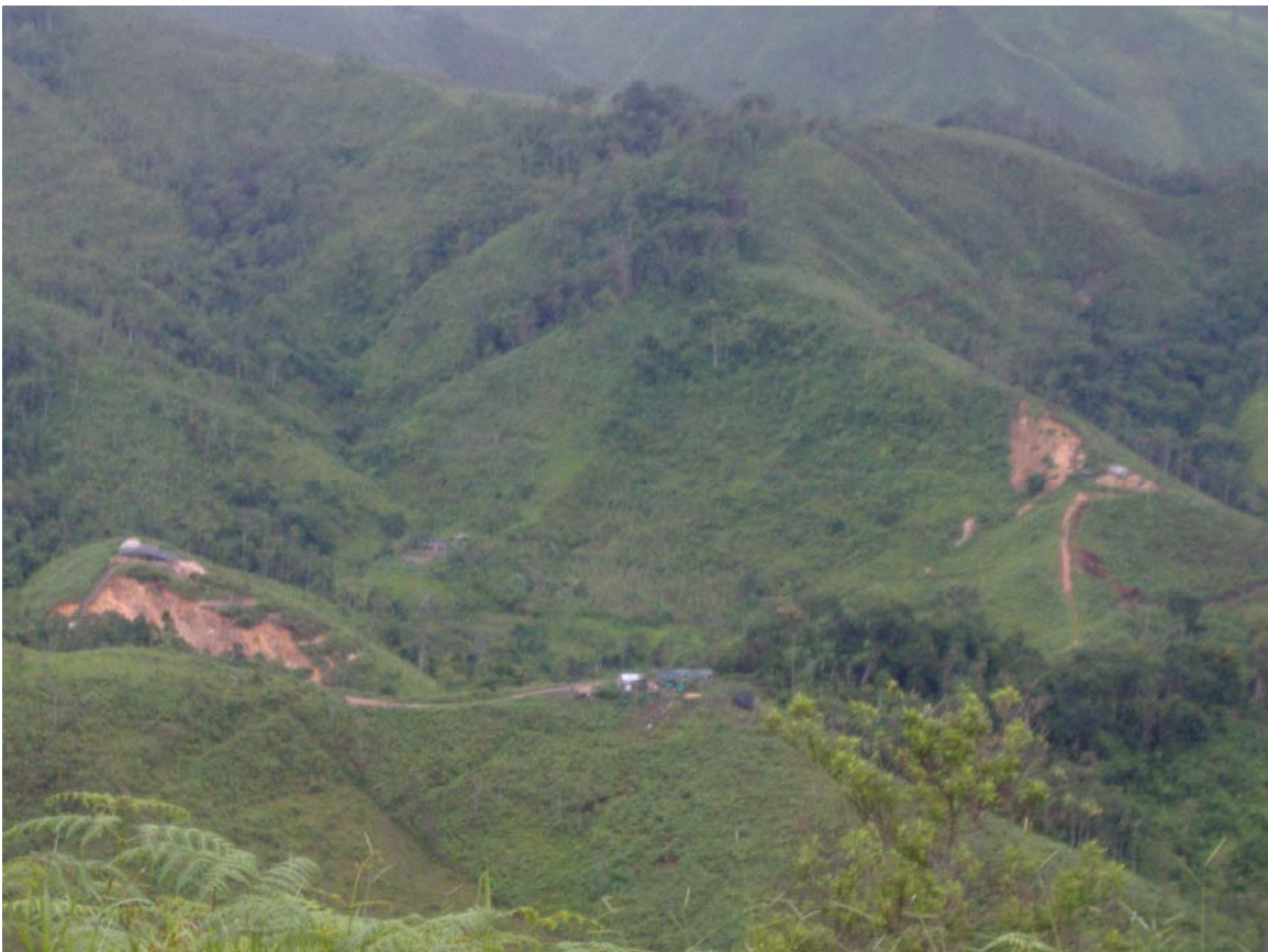
Foto 13. Erosión y Derrabes
