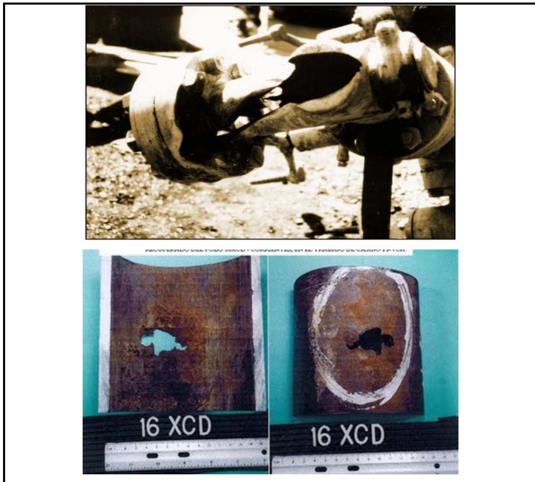
Figura 8. Erosión en superficie (arriba) y en fondo, casing (abajo).
