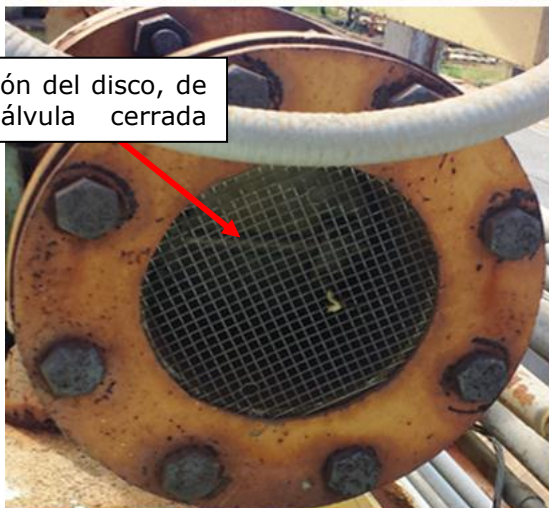
FIGURA 23. Válvulas rompe vacío VSV-29039/VSV-29043 del clarificador.
