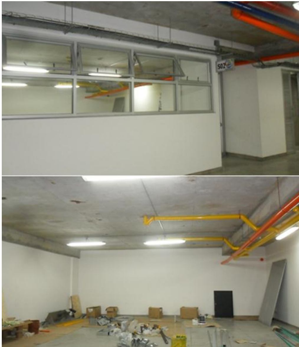
Figura 5. Sótano S02 sede Guatiguará.
