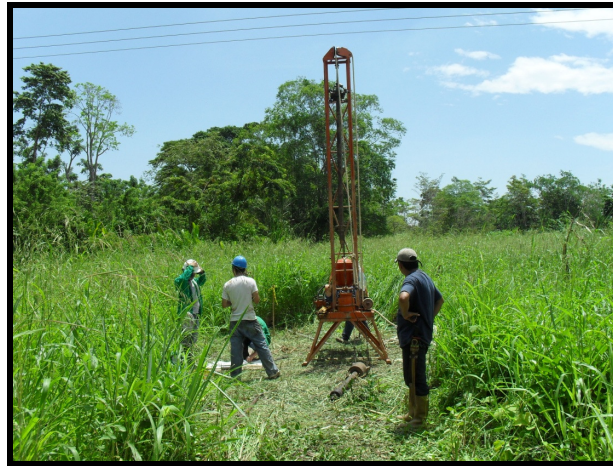
Foto 4.2 Ejecución de Sondeos
