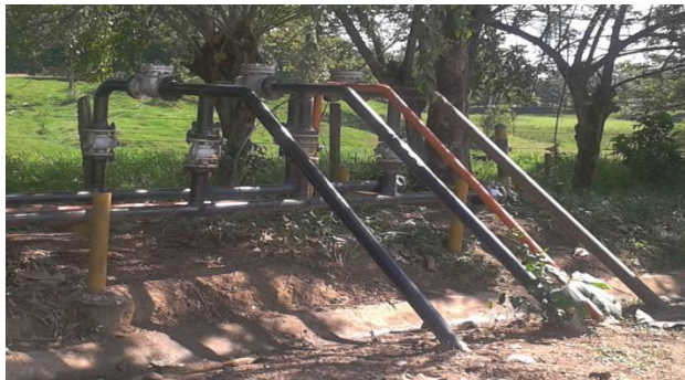
Figura 9. Manifold de Campo Velásquez.
