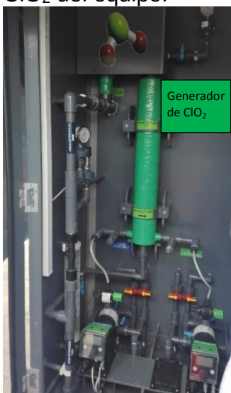
Figura R.2. a) Equipo generador de Dióxido de cloro. b) Salida de la solución de \text{ClO}_2 del equipo.
