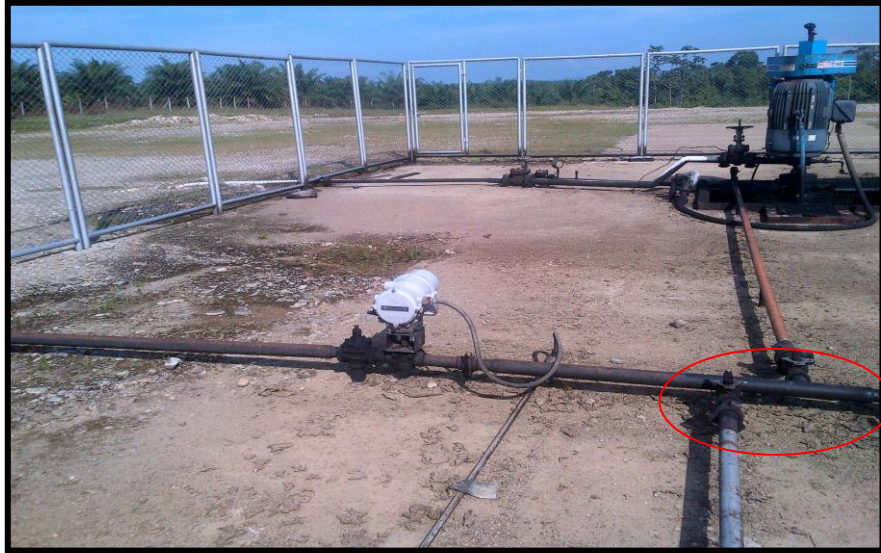
Foto 6. Conexión amulares de los pozos T-518 y T-519.
