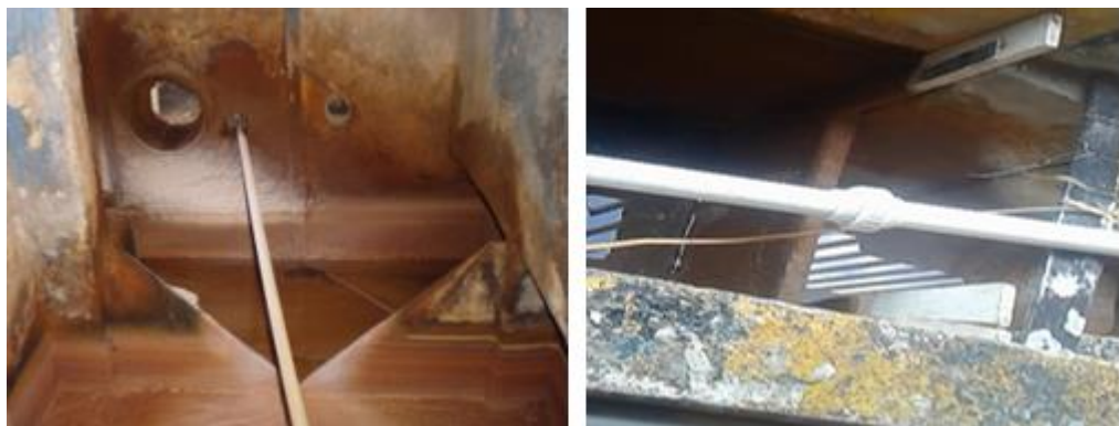
Figura 17. Vertedero planta antigua y planta nueva
