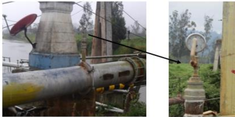
Figura 25. Manómetro ubicado al inicio de la tubería de 16 pulgadas.
