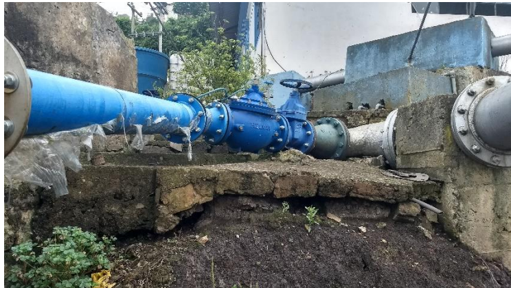
Figura 12. Válvula de alivio
