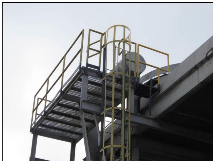
Figura 12. Tanque de expansión.
