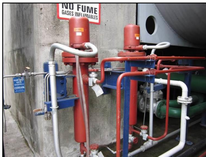
Figura 19. Interruptores de nivel LS34516 y LS34517.
