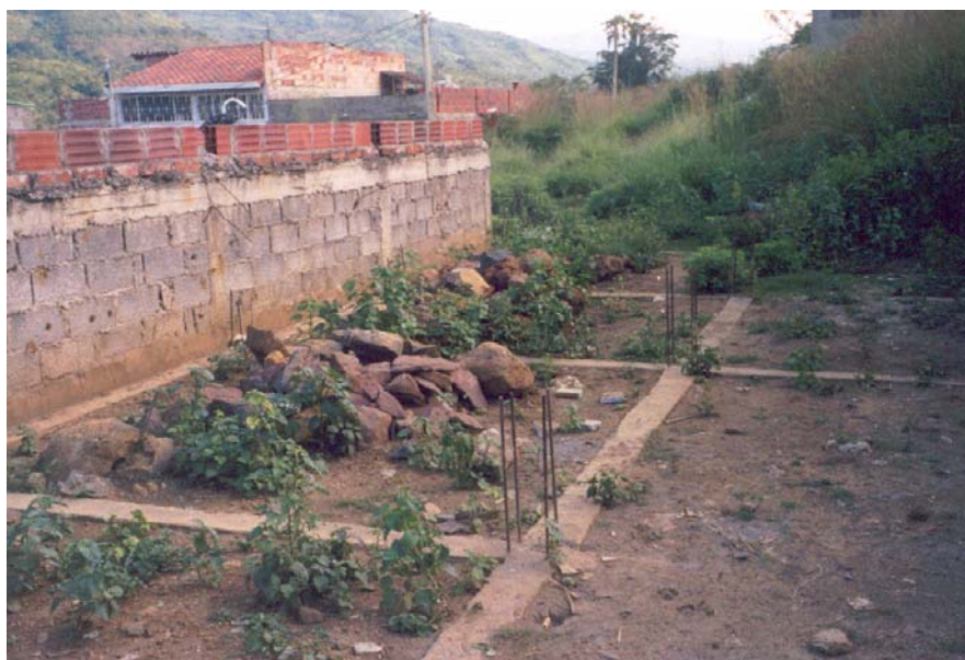
Figura 4. Avance de obra.
