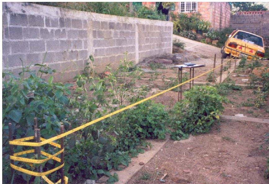
Figura 3. Medición de ejes estructurales de avance de obra.
