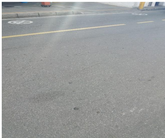
Figura 30. Pavimento en buen estado.
