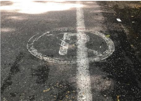
Figura 21. Señal horizontal en regular estado.
