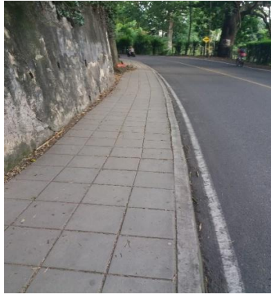
Figura 45. Anden en buen estado.
