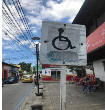
Figura 15. Señal vertical en mal estado.
