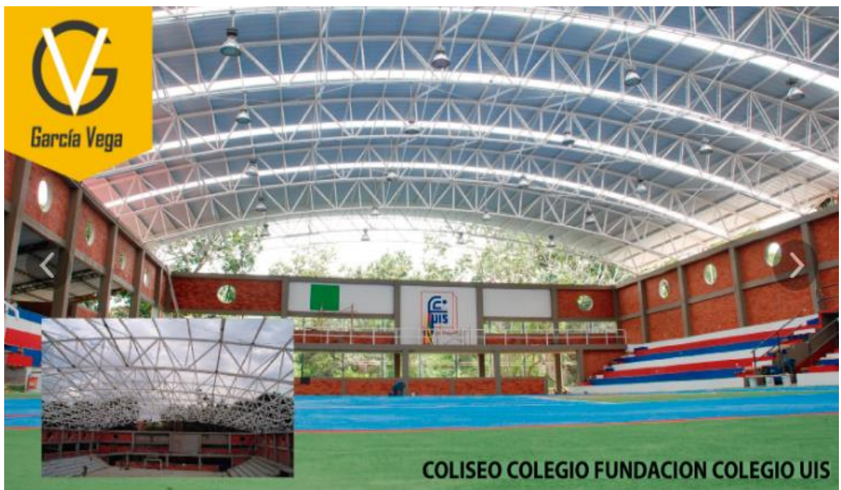
Figura 7. Cubierta coliseo fabricado por GARCÍA VEGA S.A.S.
