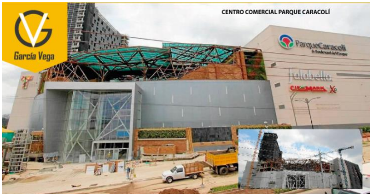
Figura 12. Estructura metálica, techo del Centro Comercial Parque Caracolí
