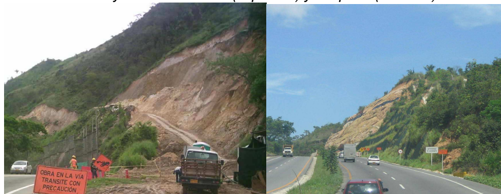
Foto 3 y 4: laderas antes (izquierda) y después (derecha).
