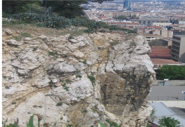
Foto 9: malla de acero. Marsella; Francia.
