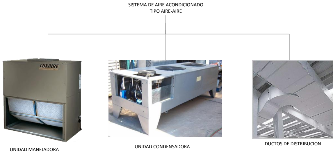
Figura 19. Composición de los sistemas de A.A todo aire.
