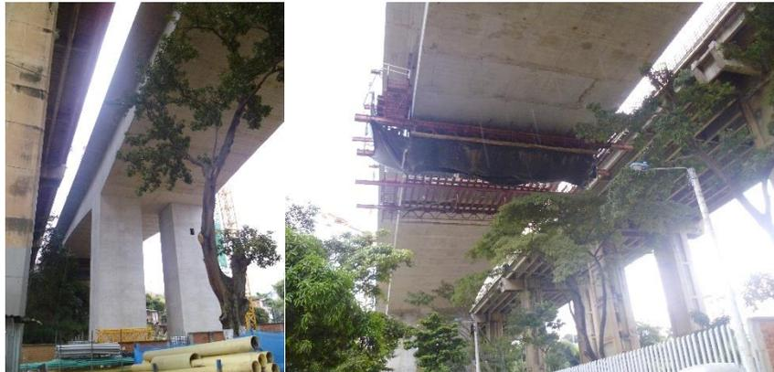
El diseño estructural de la alternativa consiste en una superestructura de cajón unicelular con puntales laterales para ensanchamiento de la sección transversal. Éste sistema fue utilizado en el puente Vidin-Calafat construido sobre el río Danubio en Bulgaria (MANTEROLA, 2015), y en el viaducto Scardon viaduct en el norte de Francia (CHEN y DUAN, 2013, p.450), ambos en Europa, cuya tipología no ha sido implementada aún en Colombia.
