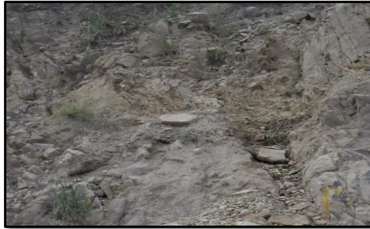
Fotografía 12: Bloques muy pequeños en cuña formados por familias de discontinuidades ortogonales de la zona
