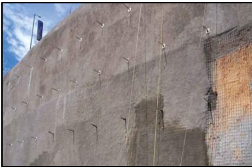
Fotografía 3: Ilustración de concreto lanzado
