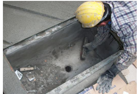
Figura 8. Limpieza superficie cárcamo
