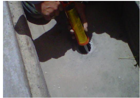
Figura 12. Aplicación Vulkem 116
