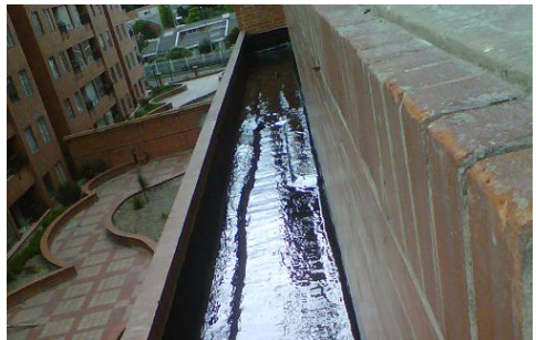
Figura 21. Impermeabilización jardinera
