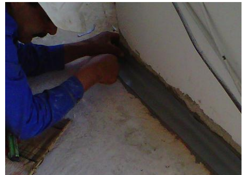
Figura 35. Instalación cinta Euco Dilaflex
