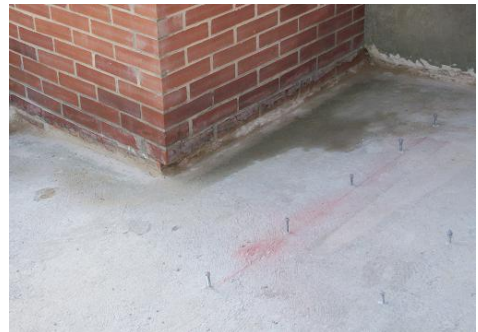
Figura 23. Cubierta sin mediacaña
