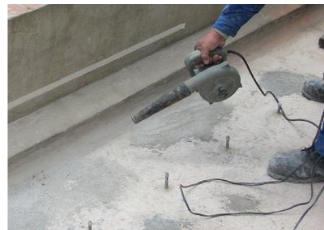
Figura 33. Limpieza sobre mediacaña
