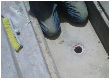
Figura 10. Limpieza bordillo sifón
