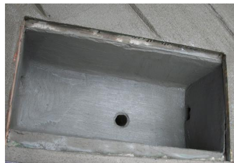
Figura 9. Impermeabilización terminada
