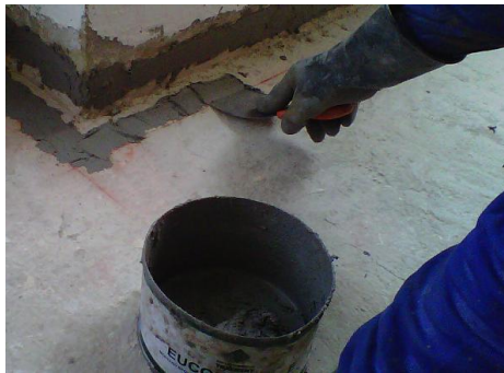
Figura 34. Aplicación adhesivo epóxico
