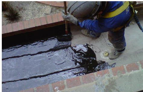
Figura 20. Aplicación Tremproof 201/60
