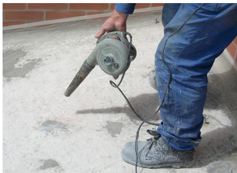
Figura 32. Limpieza superficie con soplador
