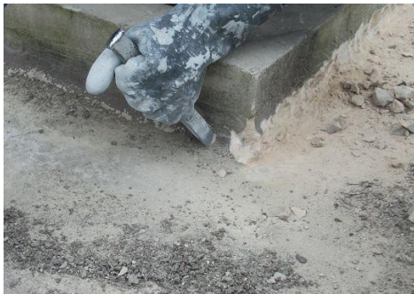
Figura 22. Demolición mediacaña
