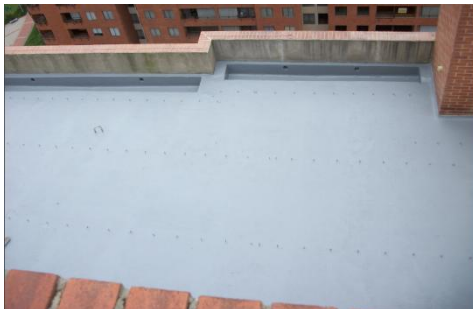
Figura 16. Impermeabilización cubierta (1)
