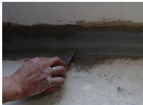
Figura 36. Segunda capa Eucopatch E
