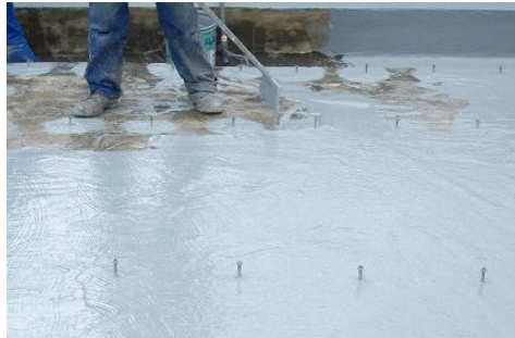
Figura 14. Aplicación Vulkem 350
