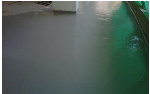
Figura 19. Impermeabilización piscina (2)
