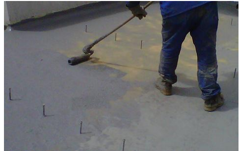
Figura 15. Encapsulando Eucofiller
