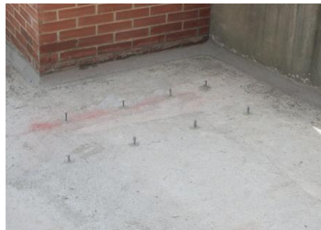
Figura 24. Cubierta con mediacaña
