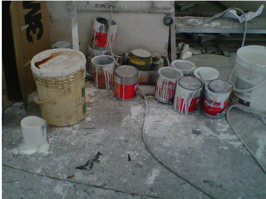
Fotografía 4 Estado Inicial Sección de Pintura
