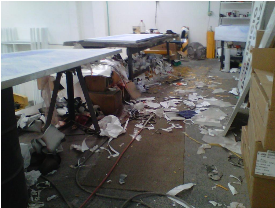
Fotografía 7 Estado Inicial Sección de Diseño Fuente: Autor del Proyecto
