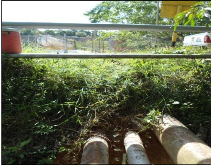
Fuente: Autor, con apoyo del Departamento de mantenimiento de GMA Ecopetrol S.A.
