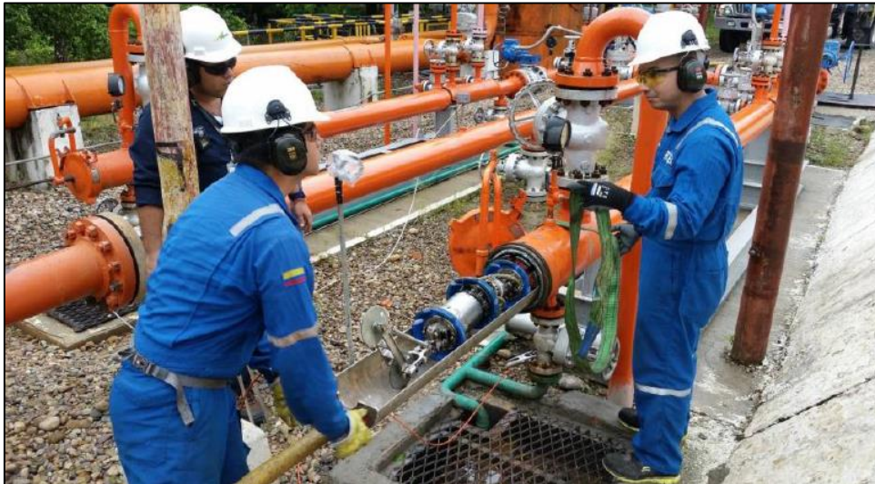
Figura 22 Lanzamiento de la herramienta ILI.
