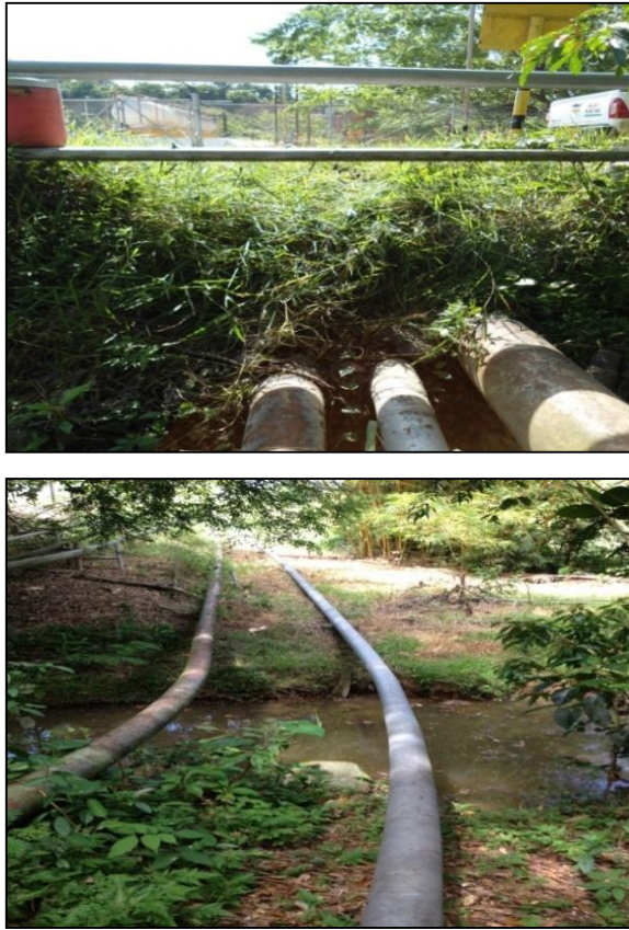
Figura 15 Gasoductos Lisama de 6" y 8" de diámetro.
