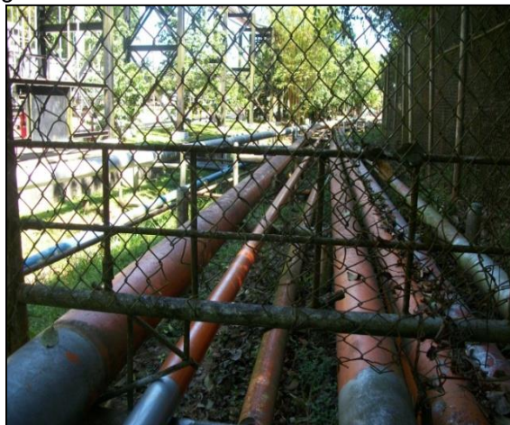
Figura 20 Punto de llegada de la línea de 8" de diámetro.
