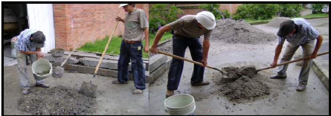
Fotografía 6.4. Fotografía que ilustra la preparación del concreto
