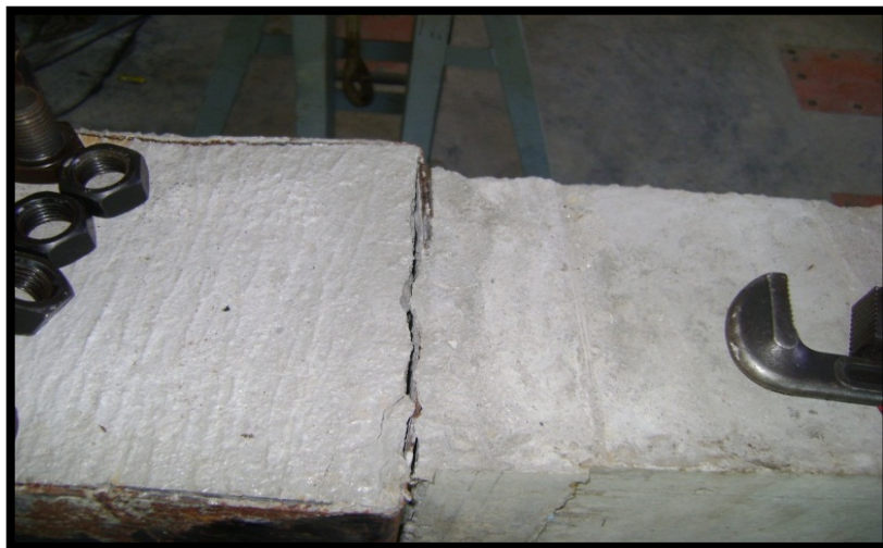
Fotografía 6.16. Inicio de la falla en el nodo 2
