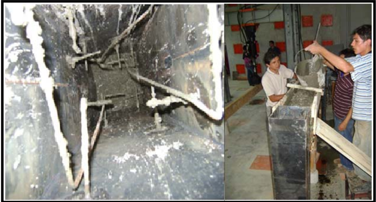
Fotografía 6.5. Colocación y vibrado del concreto en la viga (derecha) y columnas (izquierda).
