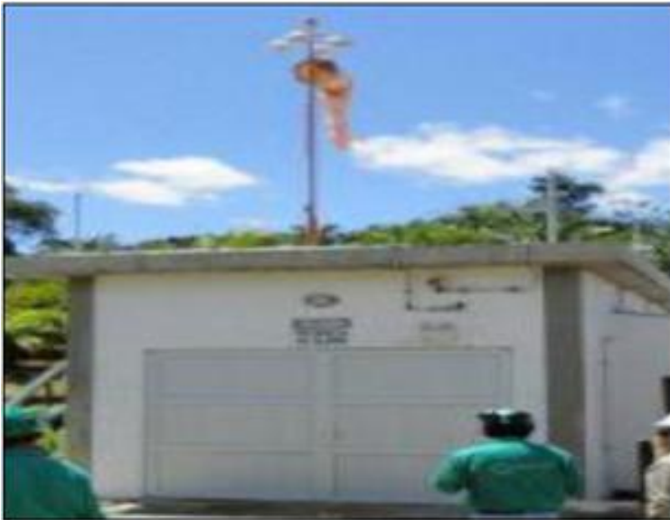
Figura 7. Caseta de almacenamiento de cloro gaseoso
