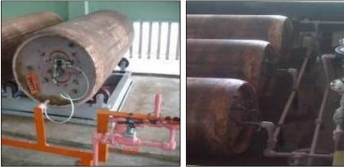
Figura 9. Sistemas de alimentación con cloro gaseoso.
