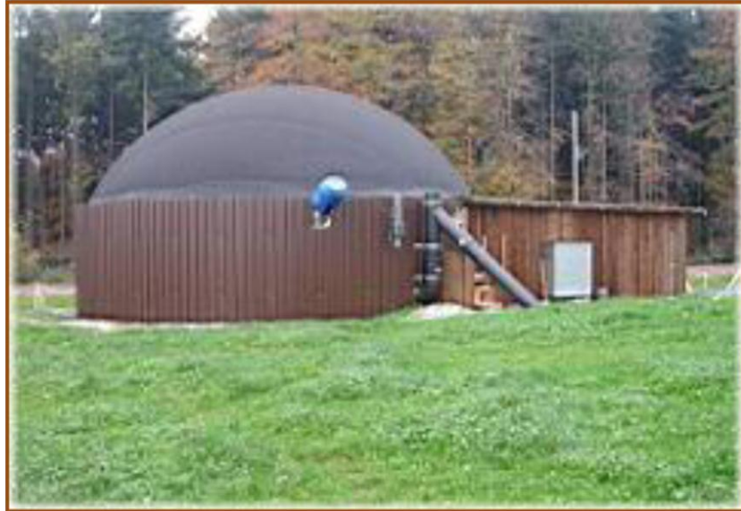
Figura 12. Biodigestor con tanque de almacenamiento tradicional y cúpula de polietileno
