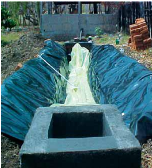
Figura 38. Zanja del biodigestor de polietileno
