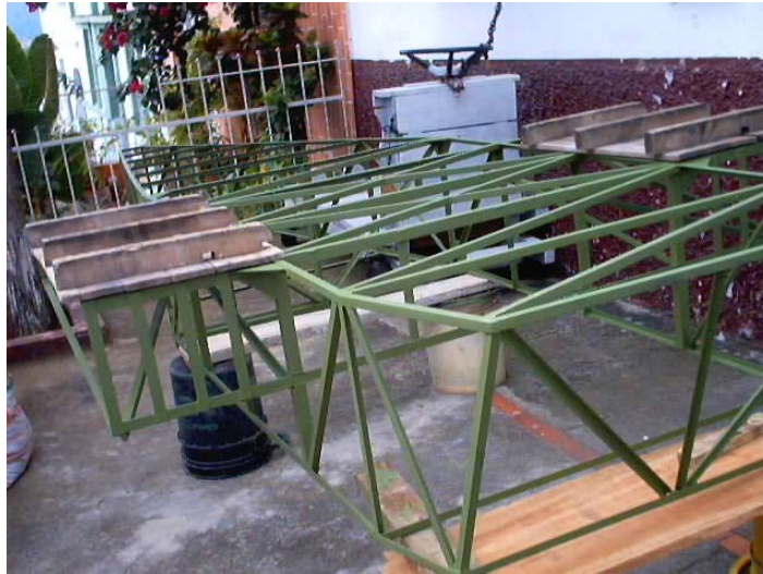
Figura 76. Detalle de la estructura
