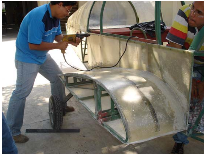
Figura 86. Detalles del forrado del fuselaje
