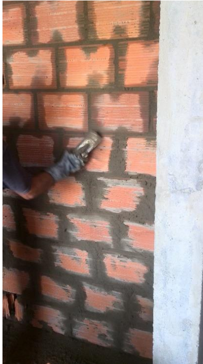
Figura 5. Muros internos en mampostería.
