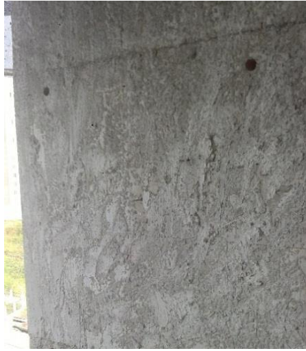
Figura 7. Muro de fachada después de realizar el “Champeo”
