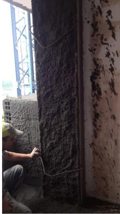
Figura 6. Friso sobre muros de mampostería.
