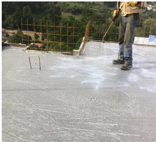
Figura 3. Curado del concreto.
