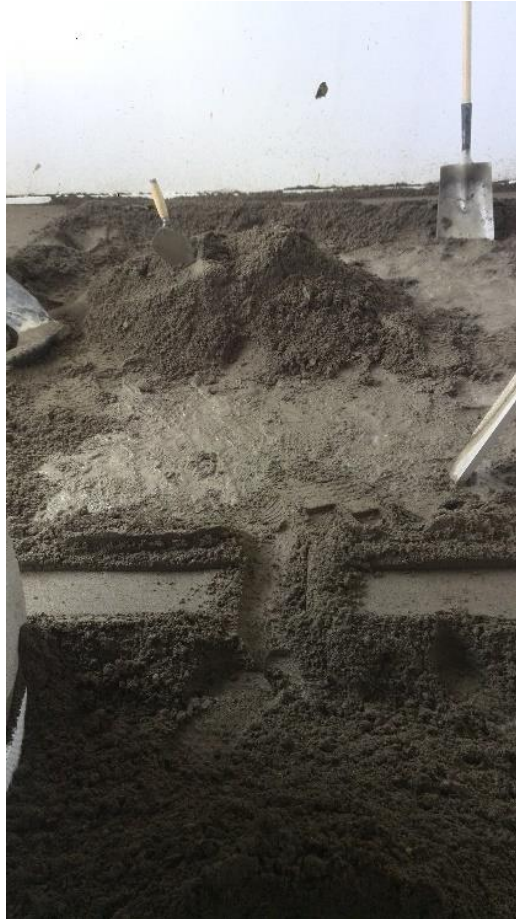
Figura 8. Mortero de nivelación sobre placas.
