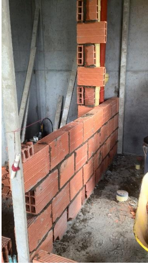
Figura 4. Muros internos en mampostería.
