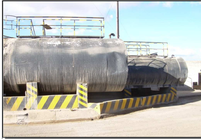
Figura 6. Tanques de almacenamiento de asfalto.
