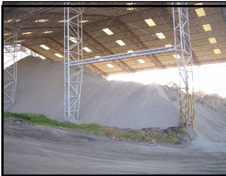
Figura 2. Acopio de materiales
