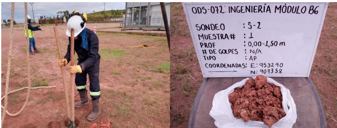
Figura 8 Realización y muestra extraída del apique hasta 1.50 metros. Fuente: SECOIN S.A.S
