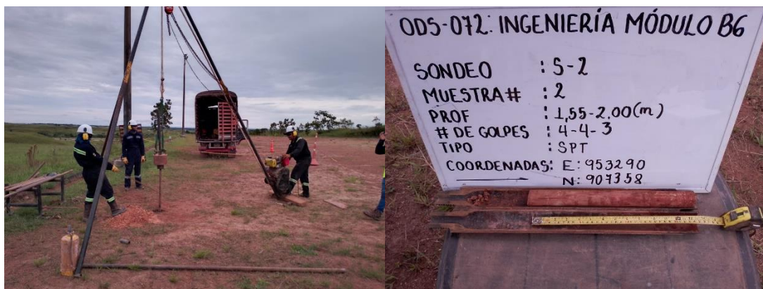
Figura 9 Realización y muestra extraída por medio del ensayo de penetración estándar. Fuente: SECOIN S.A.S
