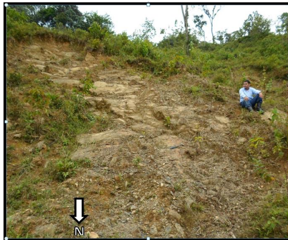
Figura 87. Fotografía del macizo rocoso MR3
