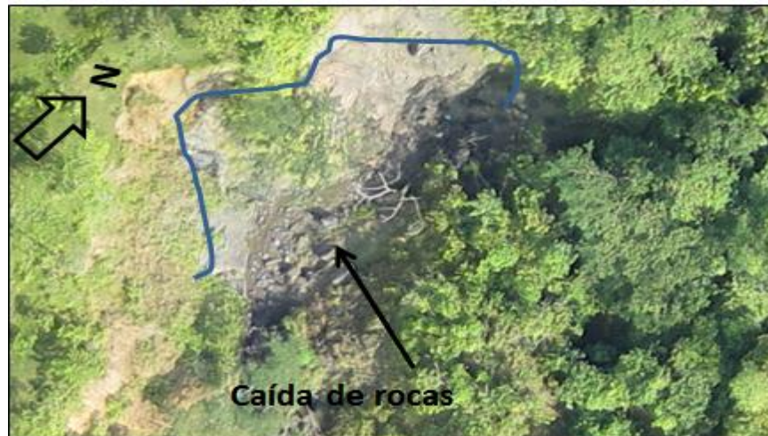
Figura 62. Caída de rocas en el Corregimiento de Alto Jordán.
