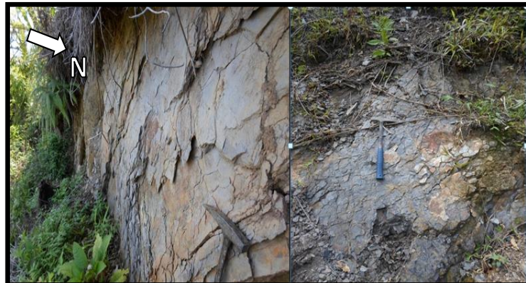
Figura 89. Fotografía del macizo rocoso MR5
