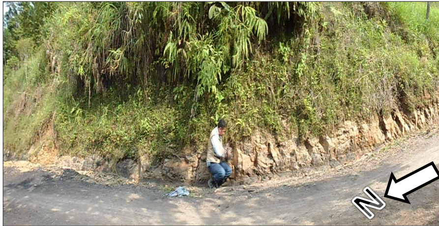
Figura 91. Fotografía del macizo rocoso MR7
