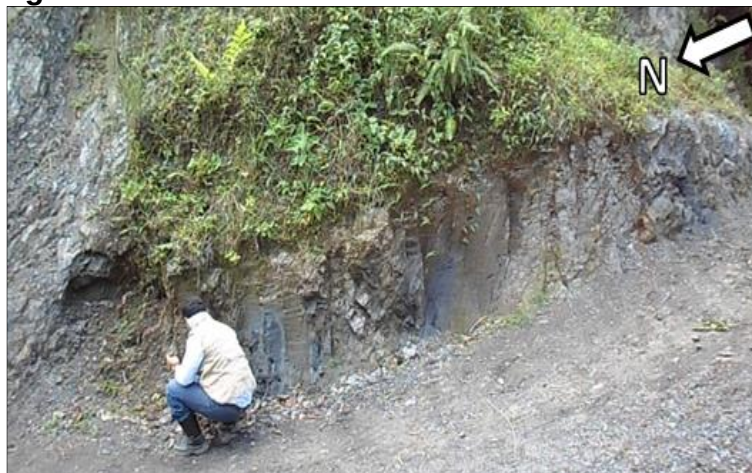
Figura 90. Fotografía del macizo rocoso MR6
