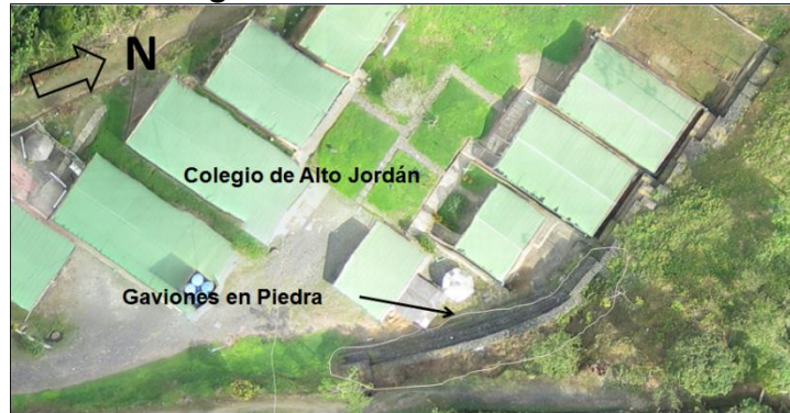
Figura 53. Vista en planta de gaviones en piedra para estabilización de taludes adyacentes al Colegio de Alto Jordán.
