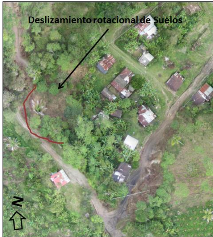
Figura 58. Deslizamientos rotacionales de suelos (Drs) presentes en el corregimiento de Alto Jordán.
