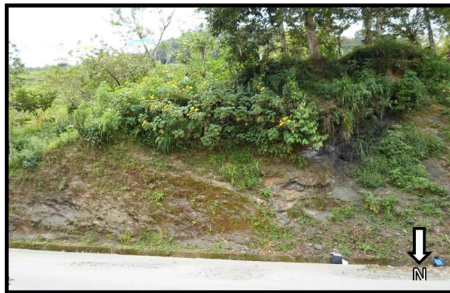
Figura 88. Fotografía del macizo rocoso MR4
