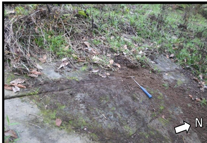
Figura 86. Fotografía del macizo rocoso MR2
