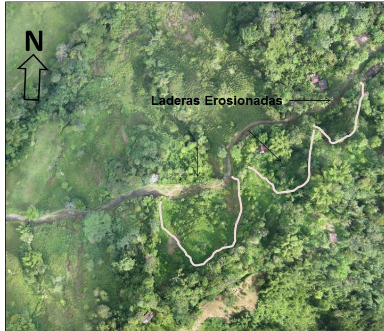
Figura 48. Vista en planta de laderas erosionadas (D20), presentes en la zona Este del sector de estudio.
