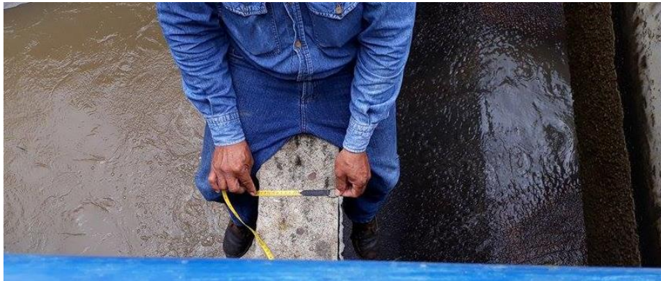
Fotografía 4. Medición del ancho de anclaje de la malla
