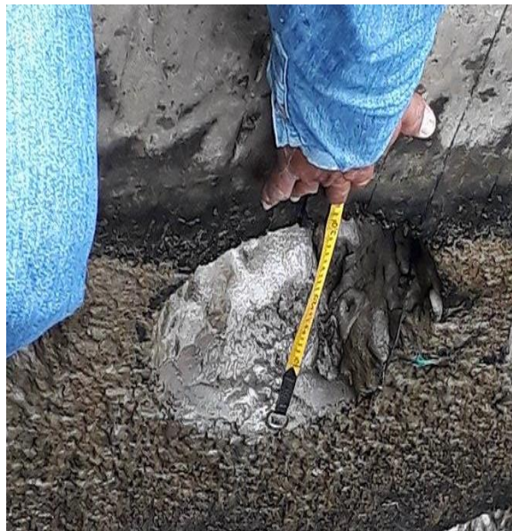
Fotografía 5. Medición del diámetro de entrada del agua al desarenador
