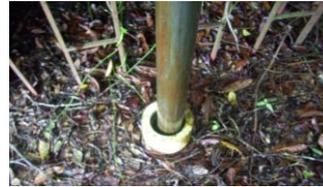
Fotografía No 2. Detalle de la tubería de succión, nótese las manchas de óxido de hierro.
