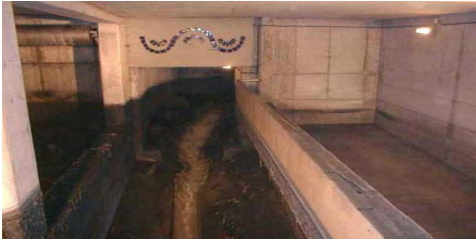
Figura 55 Depósito, control y alivio en línea
