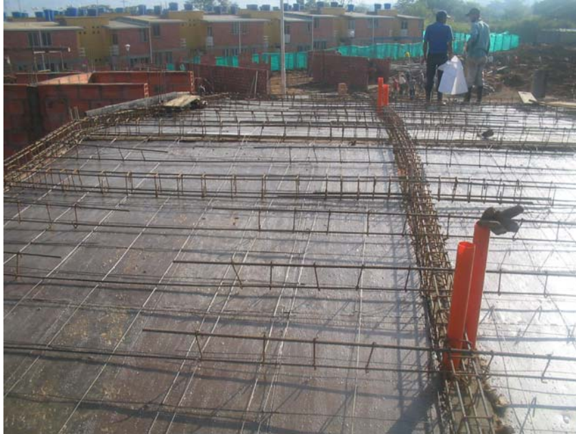
Foto 2. Detalle de refuerzo para placa de entreslabo colocado en viviendas
