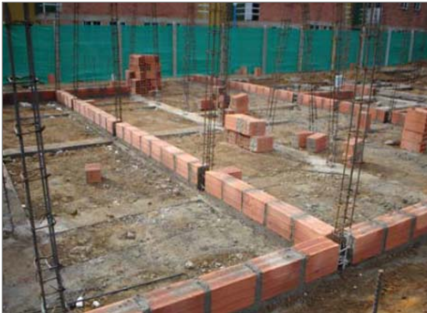
Foto 3. Detalle de refuerzo columnetas colocado en viviendas Proyecto Paseo La feria
