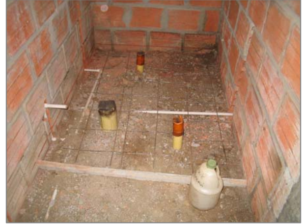
Foto 4 y 5. Detalle de Instalaciones Sanitarias, viviendas Proyecto Paseo La Feria
