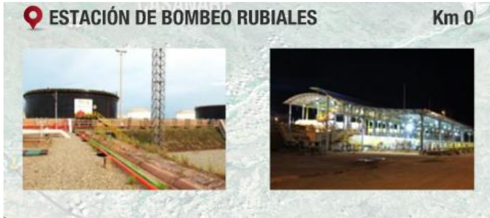
Figura 5. Estación de Bombeo Rubiales.
