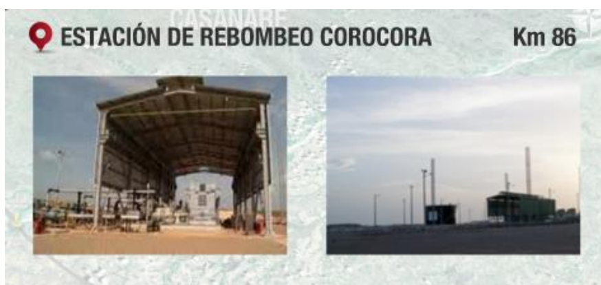
Figura 9. Caseta de bombas de la Estación Corocora
