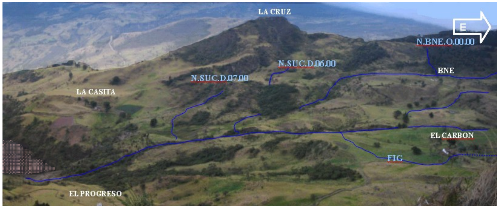
Foto 14 : Panorámica general del sector de Barro Negro y la Casita.
