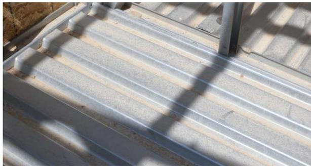
*Figura 41.* Tablero metálico apoyado sobre las viguetas
