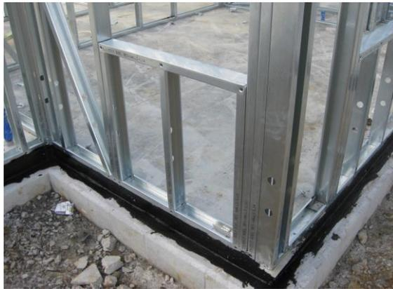
Figura 19. Perforaciones en parales conformados por perfiles en C (Framecad)
