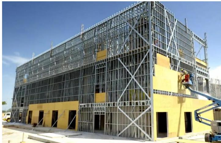
*Figura 28.* Estructura revestida en OSB (Framecad)
