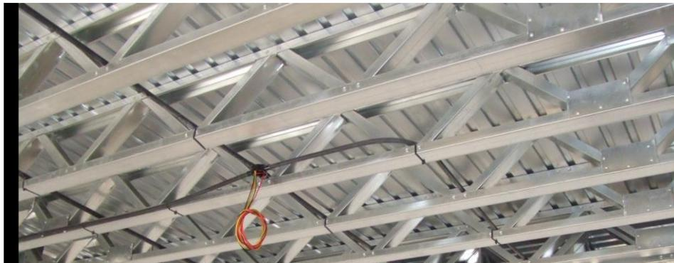
*Figura 40.* Viguetas apoyando el tablero metálico
