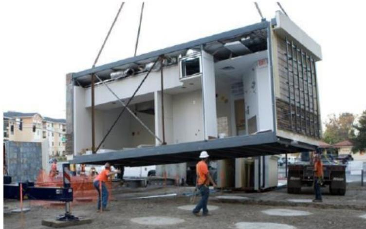
*Figura 24. Construcción modular*
