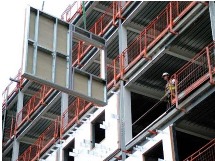
*Figura 23. Construcción panelizada (Arcelor & Staal, 2008)*
