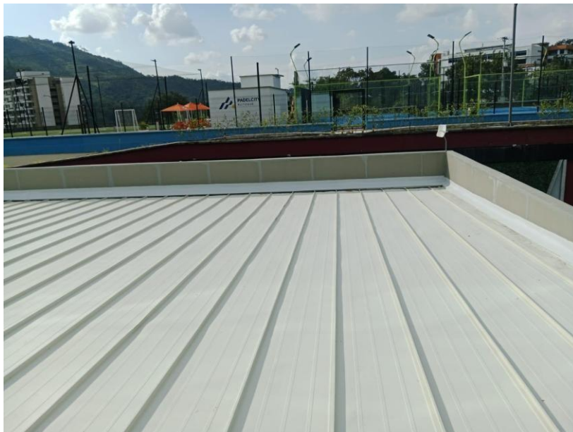
Figura 4. Zona impermeabilizada.
