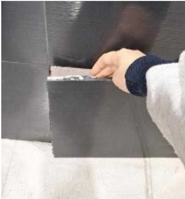
Figura 14. Daños en los ascensores
