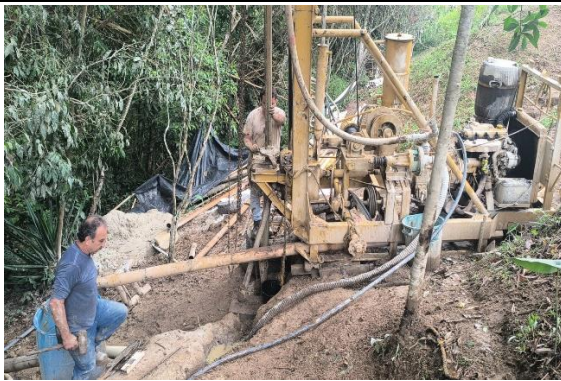
Fotografía 5. Maquinaria de perforación.
