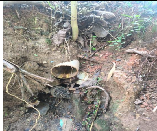
Fotografía 8: Tubería de descarga de ARD
