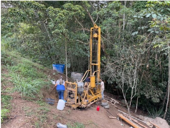
Fotografía 1. Maquinaria de perforación
