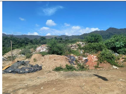
Fotografía No. 2. Condiciones actuales del sitio objeto de intervención – Disposición de RCD y residuos sólidos.
