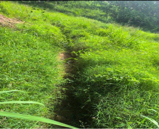
Fotografía 9: Zanga conducción de aguas lluvias
