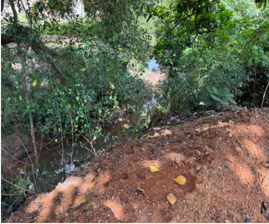
Fotografía 5: Relleno hasta el borde de fuente hídrica
