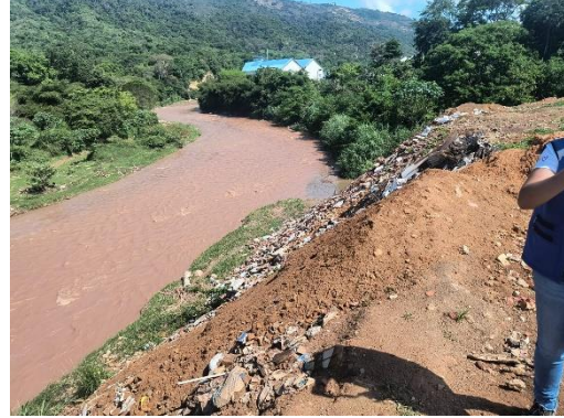
Fotografía 6. Condiciones actuales del sitio objeto de intervención - Disposición de RCD y residuos sólidos al margen derecho del Río de Oro.
