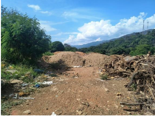
Fotografía No. 5. Condiciones actuales del sitio objeto de intervención - Disposición de RCD, residuos sólidos y biomasa.
