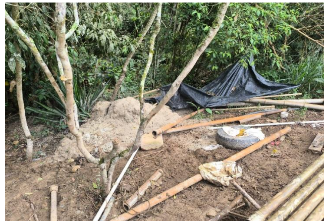
Fotografía 2. Lodo producto de la perforación.
