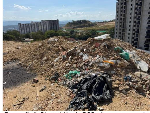
Fotografía 2. Disposición de RCD-vista parte superior.
