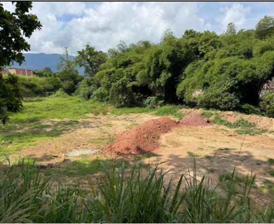
Fotografía 7. Área objeto de relleno con RCD
