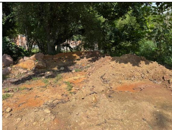
Fotografía 3. Área objeto de relleno con RCD
