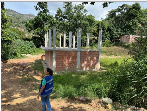
Fotografía 1. Proceso de construcción cerca a la fuente hídrica.
