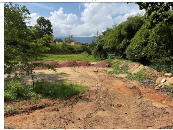
Fotografía 4. Área objeto de relleno con RCD
