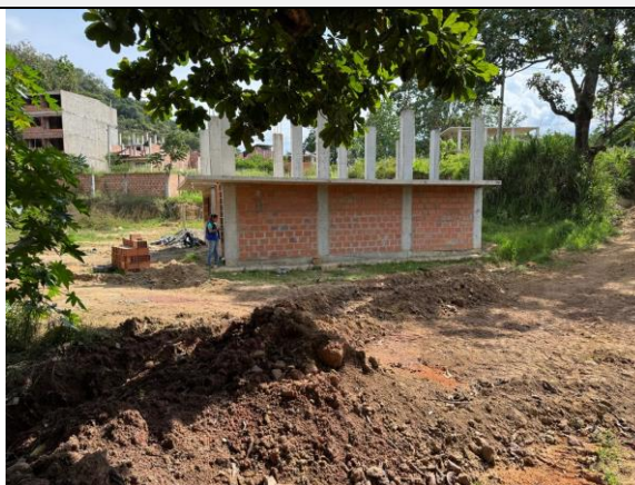
Fotografía 2: Proceso de construcción cerca a la fuente hídrica.
