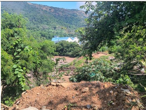
Fotografía No.1. Condiciones actuales del sitio objeto de intervención – Disposición de RCD y residuos sólidos.
