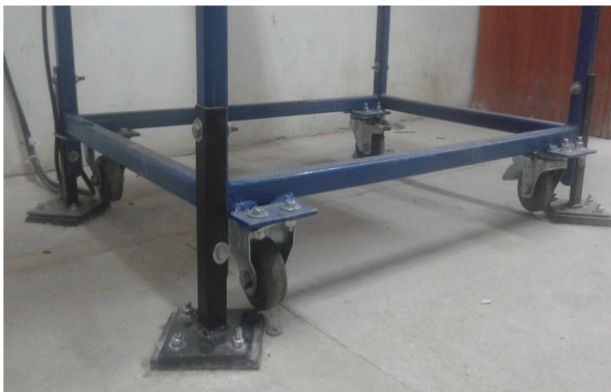
Figura 39. Anclaje al piso.
