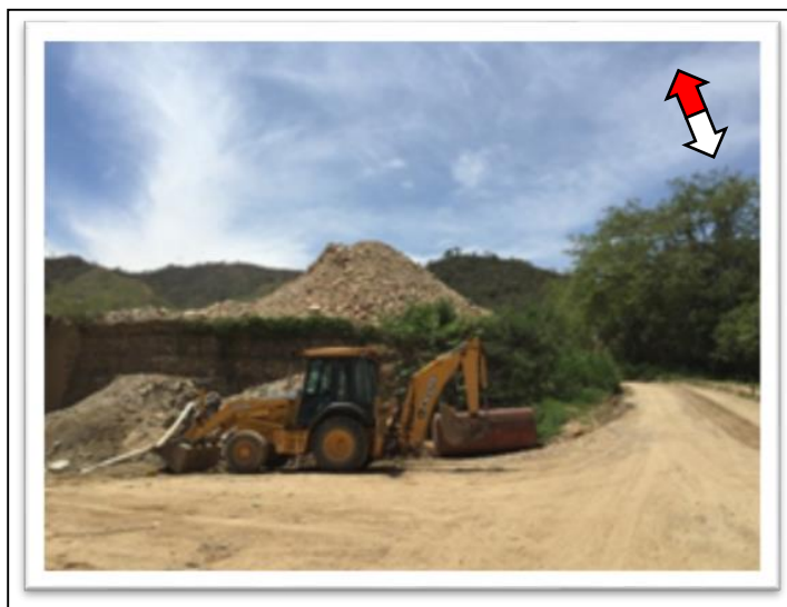
Figura 14. Arranque de material (Mecánico). Coordenadas: E 1.101.120 N 1.278.492 Z 661 msnm Cargue y transporte interno.
