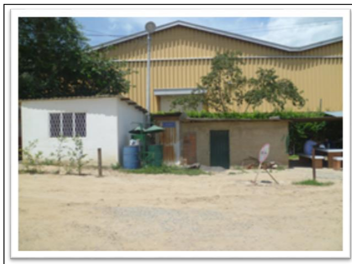
Figura 22. Unidades sanitarias Coordenadas: E: 1.101.242 N: 1.278.566 Z: 678 msnm
