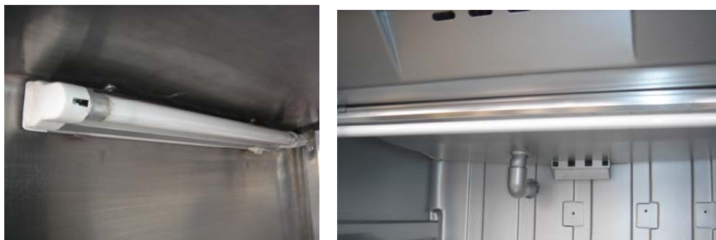
Figura 15. Alumbrado de las cámaras superior (izq.) e inferior (der.)
