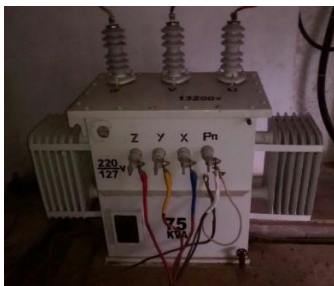
Figura 6. Características de transformador de 75 kVA
